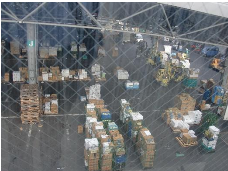
屋根付積込場
