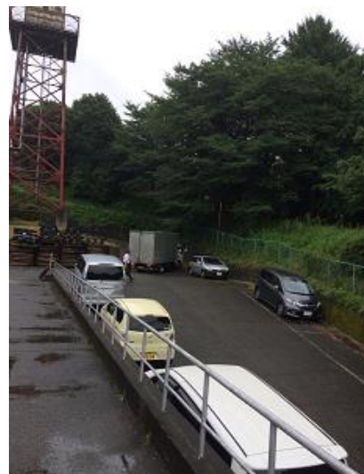
工場は山を切り取って建てられている。
